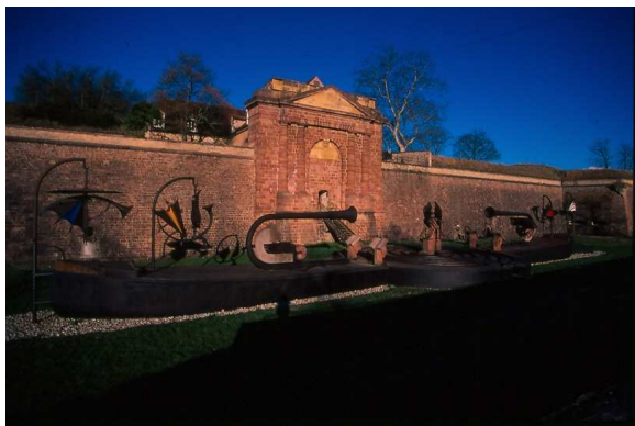
Porte de Belfort – Remparts de Neuf-Brisach
